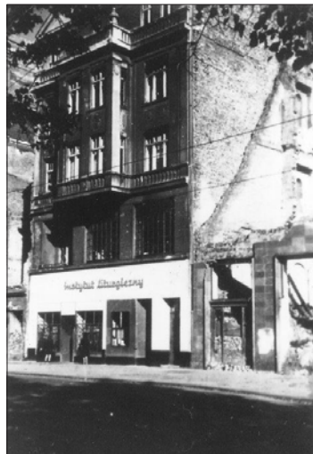
Budynek przy ul. Niepodległości 17 – druga połowa lat czterdziestych XX wieku – AP Szczecin, Zbiór relacji i wspomnień, sygn. 54.
