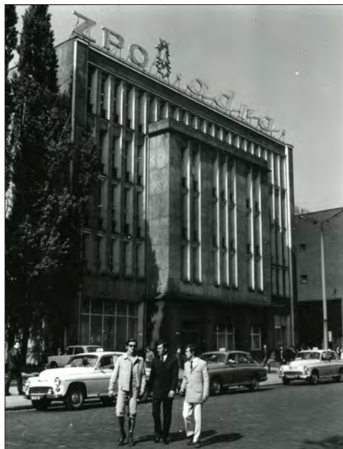
Fot. 3. Budynek ZPO „Odra” w Szczecinie, mieszczący się przy al. Niepodległości 38. APSz, „ZPO „Odra” w Szczecinie, sygn. 155.
